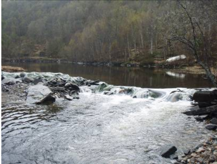
Demningen ved Gardsvatnet. Til venstre er den delen av demningen hvor Gardsvatnet vanligvis holdes tilbake.
