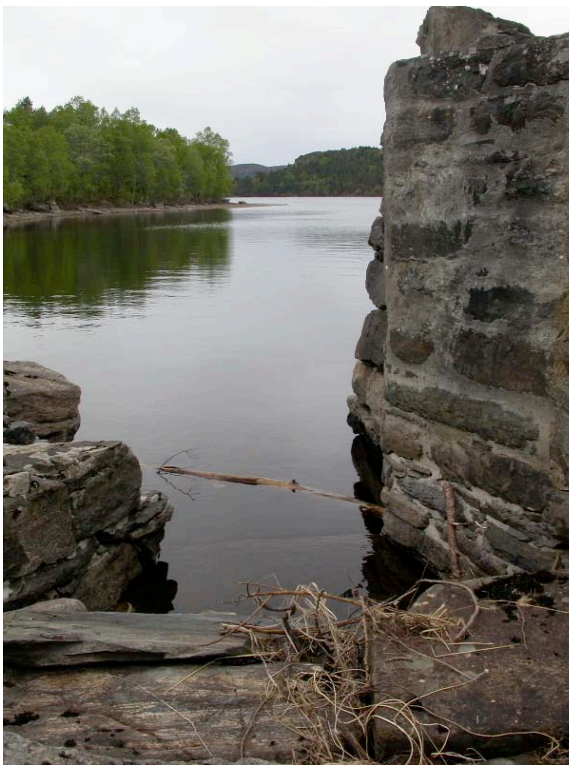
Figur 6. Den lekke demningen i Storstvatnet sett fra damkrona. Under vårt besøk stod vatnet antagelig minst 1/2 meter under nivå for overløp.
